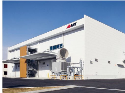
2016年4月に開所したスマートシステム研究棟：太陽光発電用大型パワーコンディショナ（大型PCS）等の分散電源システムの高機能化に向けた先端的研究開発及び試験評価ができる世界最大級の施設
