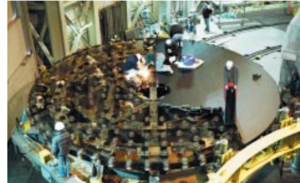
図2 すばる望遠鏡の主鏡ガラス全体像
