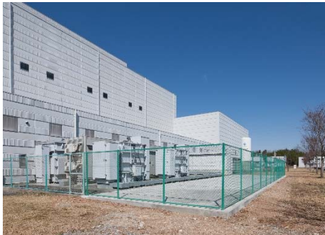
核融合科学研究所大型ヘリカル実験棟改修 (左) 改修後のトランスヤード (右) 改修後の保守作業室
