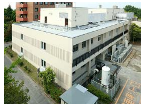
岡崎共通施設棟 I
