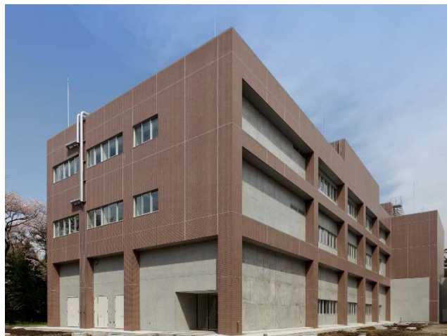
三鷹開発棟 3 号館 (国立天文台)
