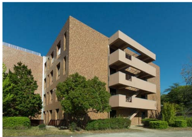
改修した実験研究棟 (基礎生物学研究所)
