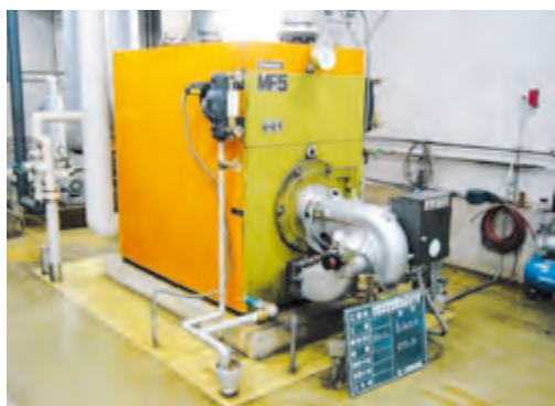
環境配慮と省エネの両立を図った都市ガス型ボイラー設備に改修（左:改修前、右:改修後）
