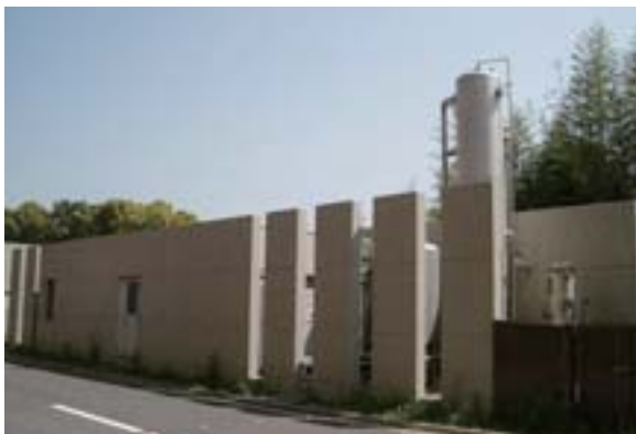
山手排水処理施設及び中水処理施設
