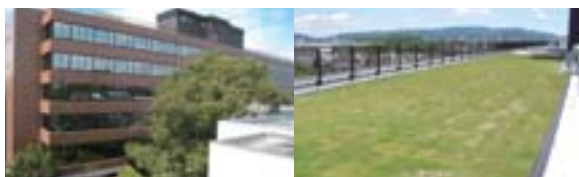
改修工事の行われた分子研実験棟(左:外観、右:屋上緑化)
