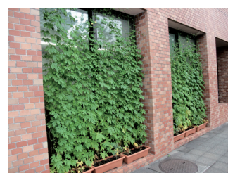
岡崎統合事務センター棟 (グリーンカーテン)
