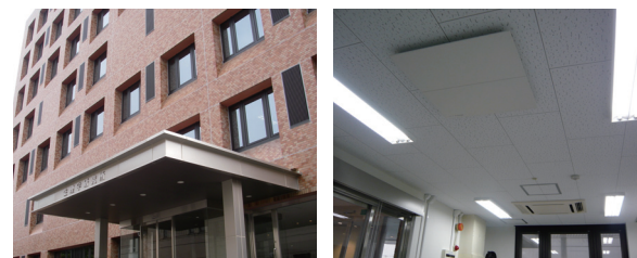
改修工事の行われた生理研実験棟 (左:左観複層ガラス、右:高効率空調機+全熱交換器)
