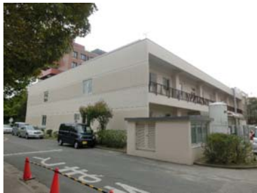
改修工事が完了した共通施設棟Ⅰ 外観
