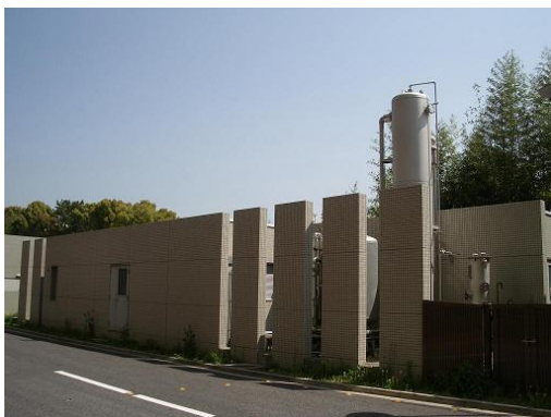
山手排水処理施設及び中水処理施設
