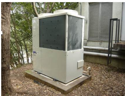
ガスヒートポンプ式空調機更新 （岡崎3機関）
