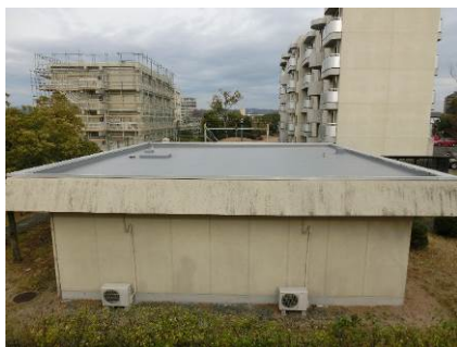
断熱防水（岡崎3機関）
