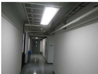
基生研実験研究棟改修電気設備工事のLED照明更新（岡崎3機関）
