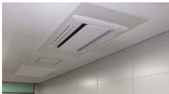
計算科学研究センター棟218号室他の空調設備改修（岡崎3機関）
