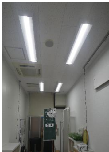
山手3号館4階420室の LED照明更新（岡崎3機関）
