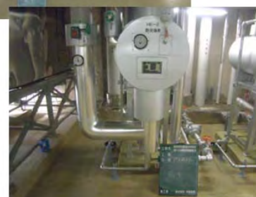
2015(H27) (土岐) 大型ヘリカル実験棟 空調熱源設備改修
