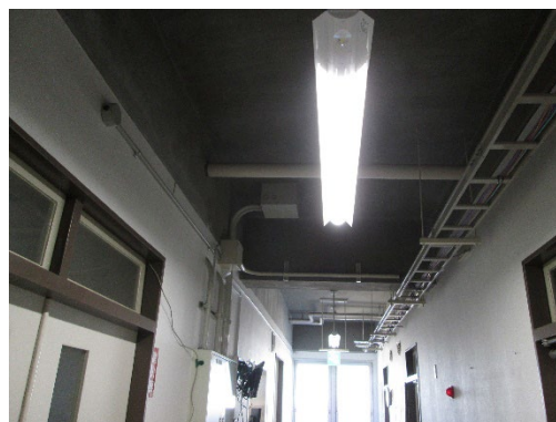
（明大寺）共同研究棟UVSOR棟 照明設備（LED化：57台）改修
