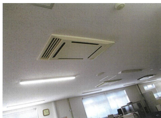
分子科学研究所、実験棟、空調機器（更新）
