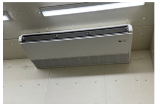
核融合科学研究所、空調設備新設
