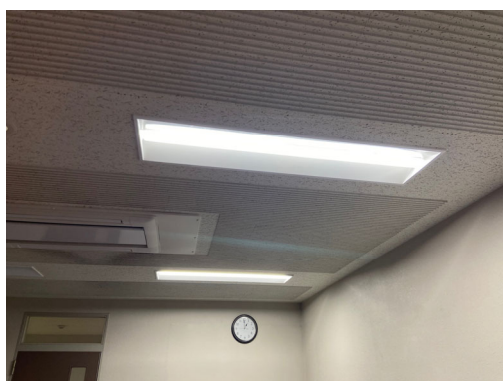
計算科学研究センター棟2階西側
