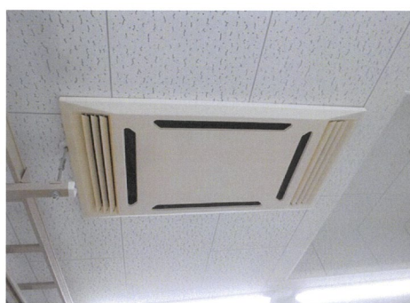
（明大寺）共同研究棟Ａ棟１階の空調設備（空調高効率化）改修
