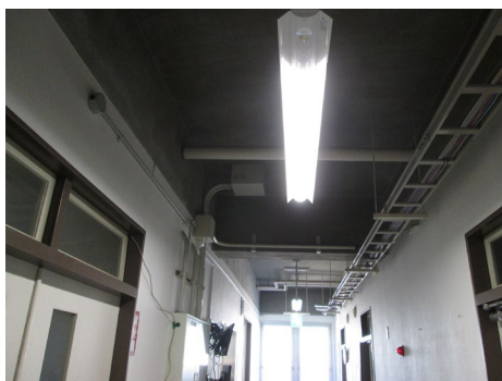
（明大寺）共同研究棟ＵＶＳＯＲ棟の照明設備（ＬＥＤ化：５７台）改修
