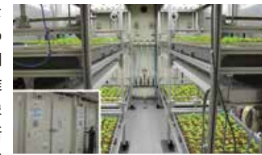
植物環境制御システム(ネットワークカメラにより遠隔地からの長期環境応答モニタリングが可能)
