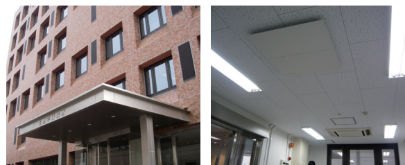
改修工事の行われた生理研実験棟 (左:左観複層ガラス、右:高効率空調機+全熱交換器)
