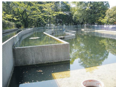
明大寺A実験廃水処理施設放流池 研究所の実験排水を処理して下水に流す前の水を池に入れてあります。 水生植物が植えられており、鯉や金魚が泳ぎ、サギやセキレイなどの水辺の鳥も訪れています。
