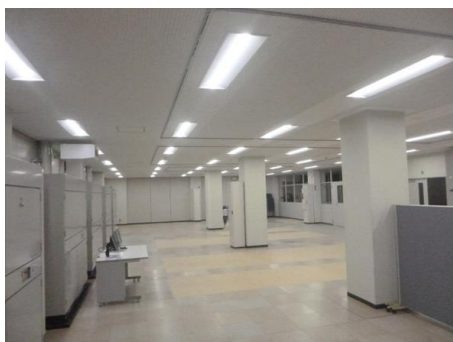
計算科学研究センター棟のLED照明更新（岡崎3機関）
