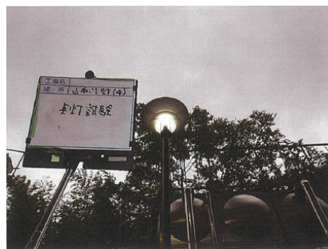
(明大寺・山手・三島・竜美) 屋外照明設備（岡崎3機関）
